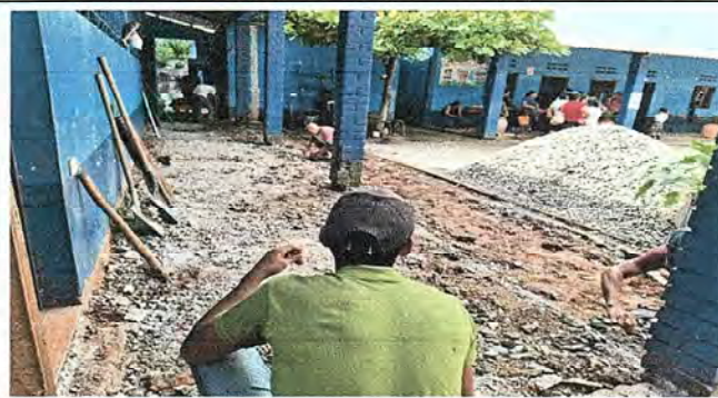
Foto 8: Reparación de piso de cemento liquido en modulo 3
