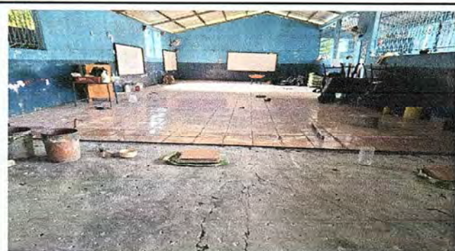
Foto 9: Sustitución de piso de cemento liquido por ceramico modulo 3
