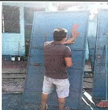
Foto 3: mantenimiento de puerta (lijado y pintura)
