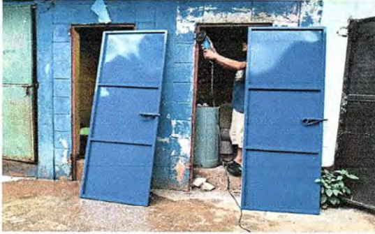
Foto13: Fabricación e instalación de puerta de metal de baños
