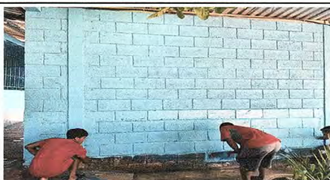
Foto 10 : Pintura de muros de exteriores módulo 4
