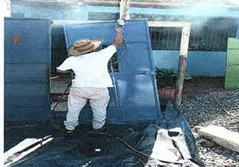
Foto 2: mantenimiento de puerta (lijado y pintura)
