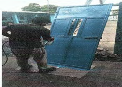
Foto1: mantenimiento de puerta (lijado y pintura)
