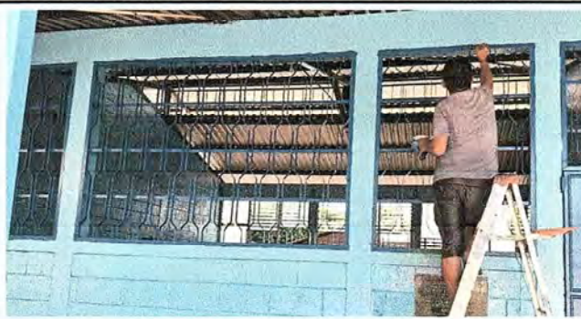
Foto 6: Mantenimiento de balcones de metal (lijado y pintura)
